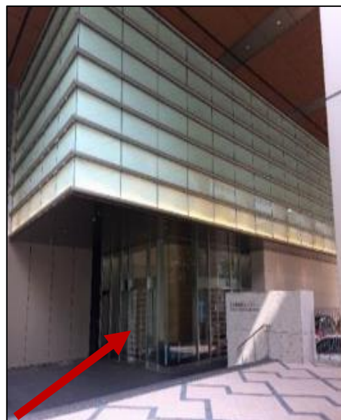
1階 北側入口(神田駅方面から)の写真
